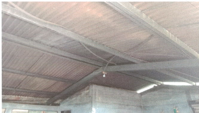
Foto1: Sustitución cubierta de lámina y estructura de techo
