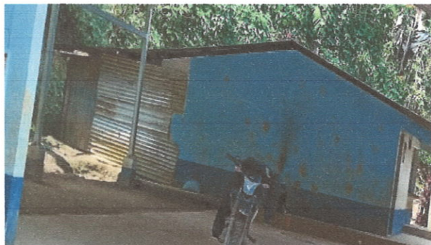
Foto 3: Mejoramiento de bodega de cocina
