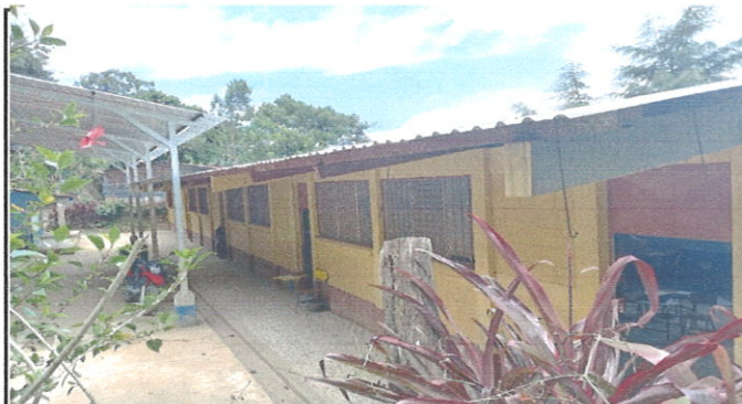
Foto 6: Instalación de canaletas y bajadas
