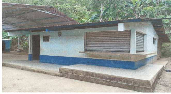
Foto 2: Mejoramiento de altura de cosina
